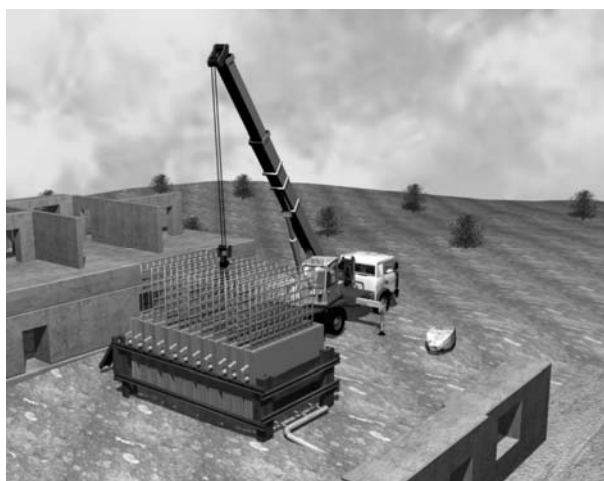
Рис. 7. Армирование установки
