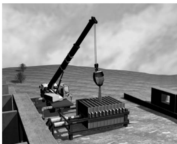
Рис. 8. Подача бетона в установку
